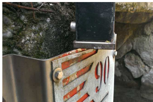
Sommità asta idrometrica Torrente Acquanegra
